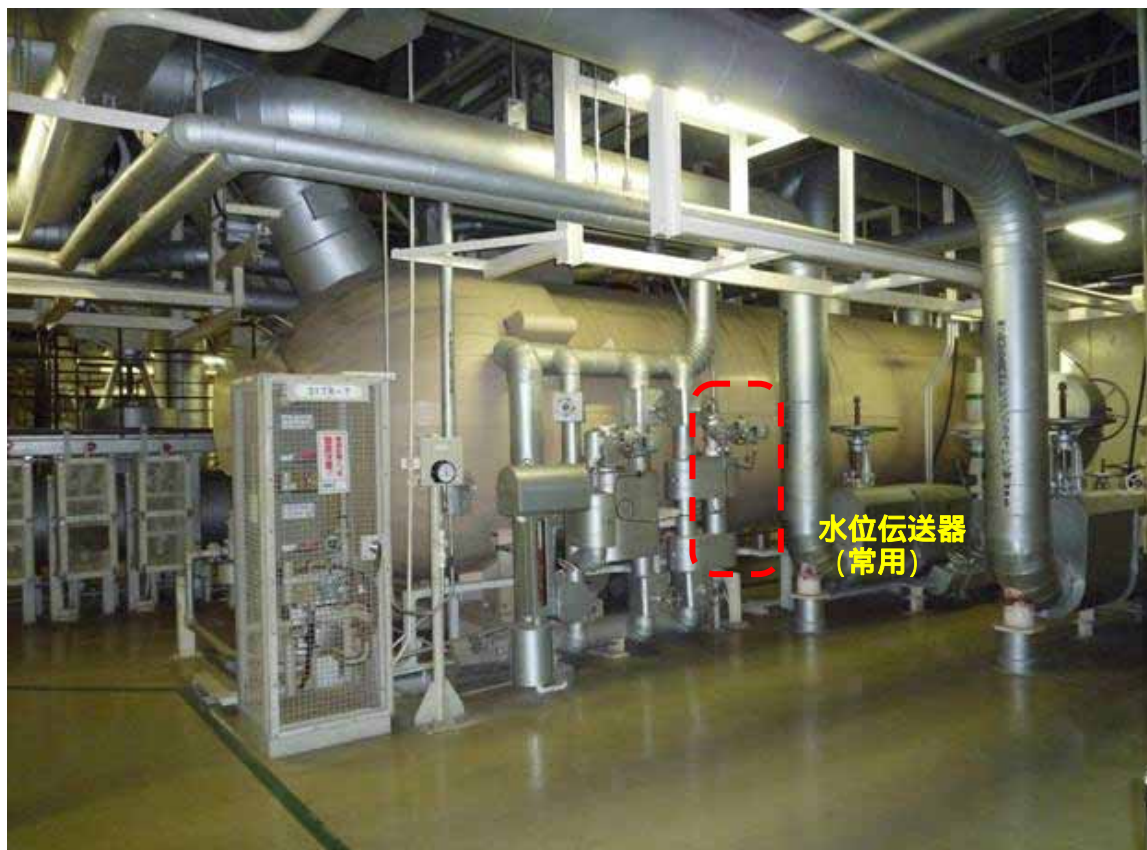
伊方発電所第3号機 第6 高压给水加热器 3 A ドレン水位 (常用) 伝送器
