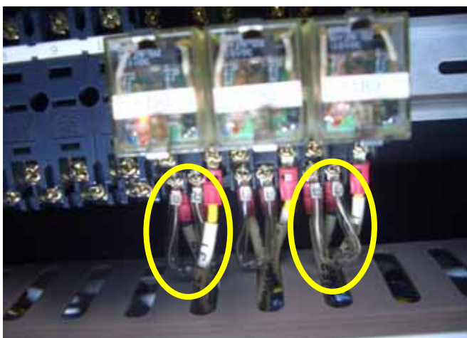
排気ファン 3 A 及び 3 C のサージキラー 取替後
