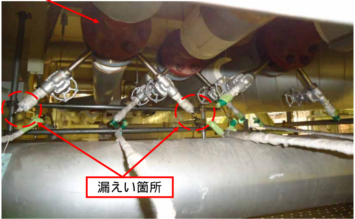
蒸気発生器ブローダウン3C配管
