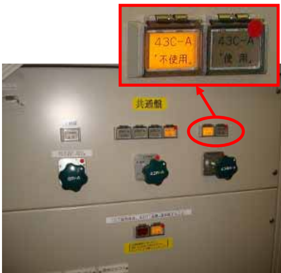
保護リレー状態表示「不使用」
