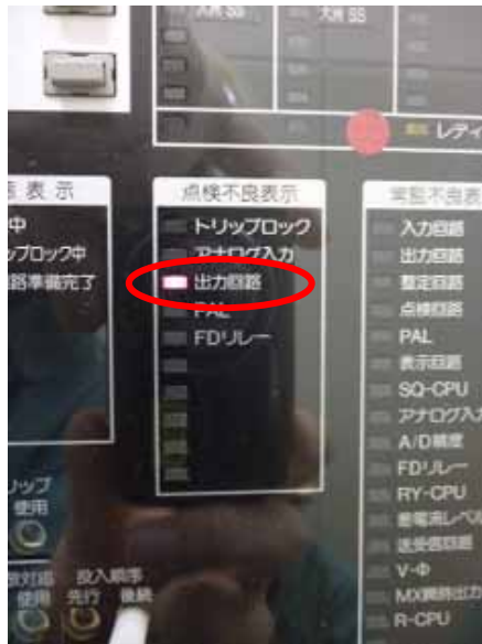
点検不良表示「点灯」
