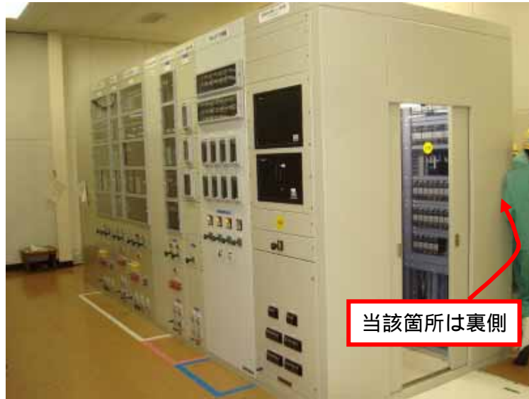
保護リレー盤(全景)
