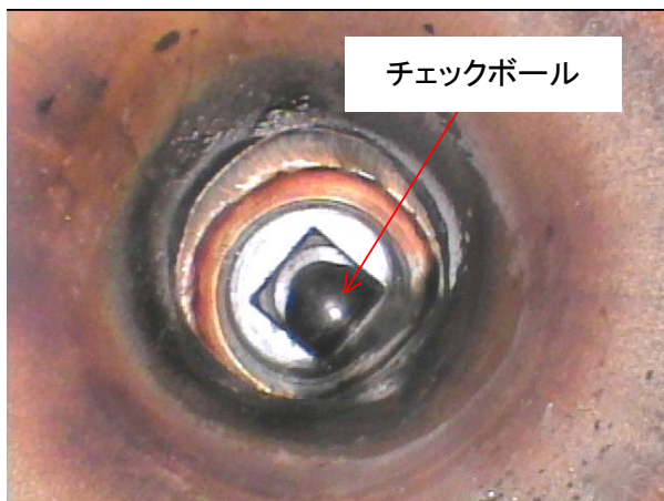
ファイバースコープによる下部液面計元弁内面点検 (弁分解前)
