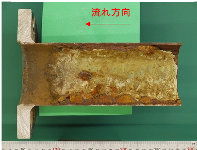
当該部堆積物除去後の内面状況(天側)
