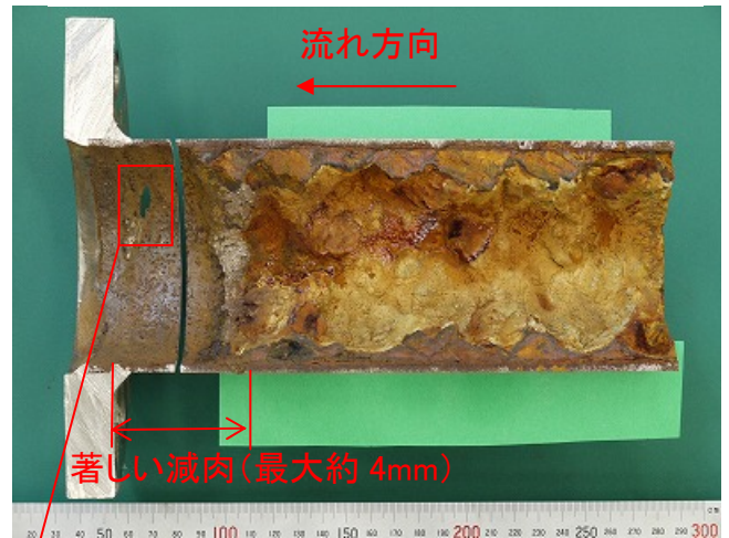
当該部堆積物除去後の内面状況(地側)
