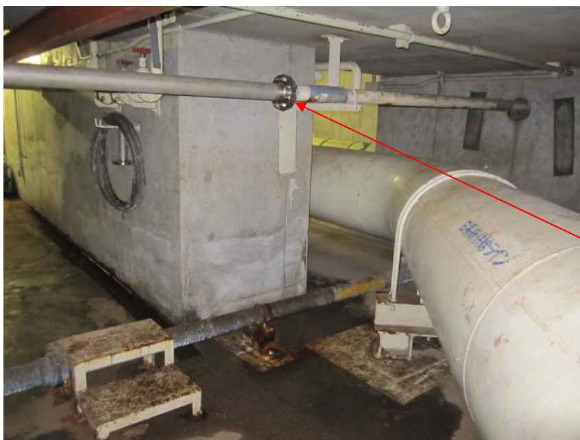
現場状況写真
