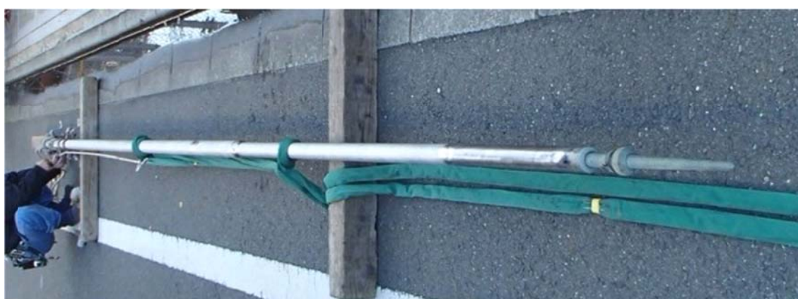
上端部と下端部以外を取替えた避雷針
