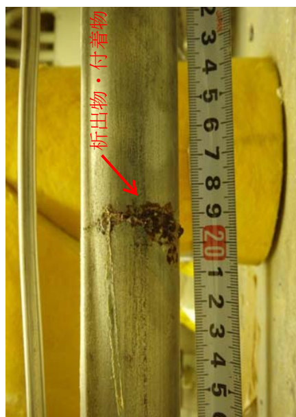
【右側（手入れ前状況）】
