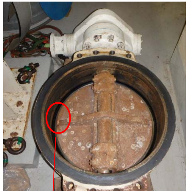
B 矢視 (点検後)
