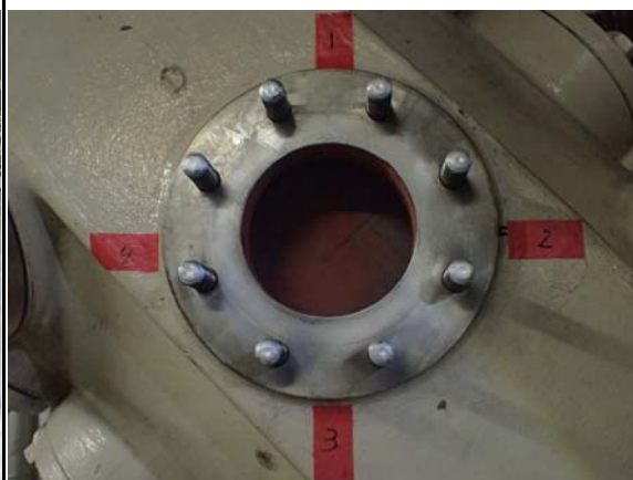
制御用空気圧縮機のフランジ面 (普通鋳鉄製、全面座フランジ)
