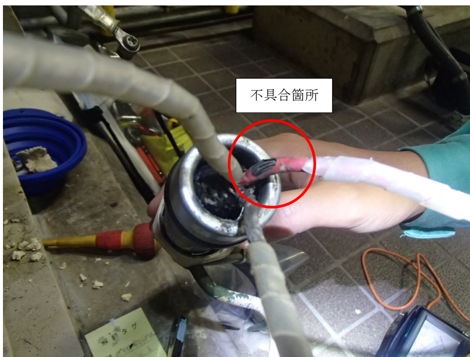
ケーブル不具合状況
