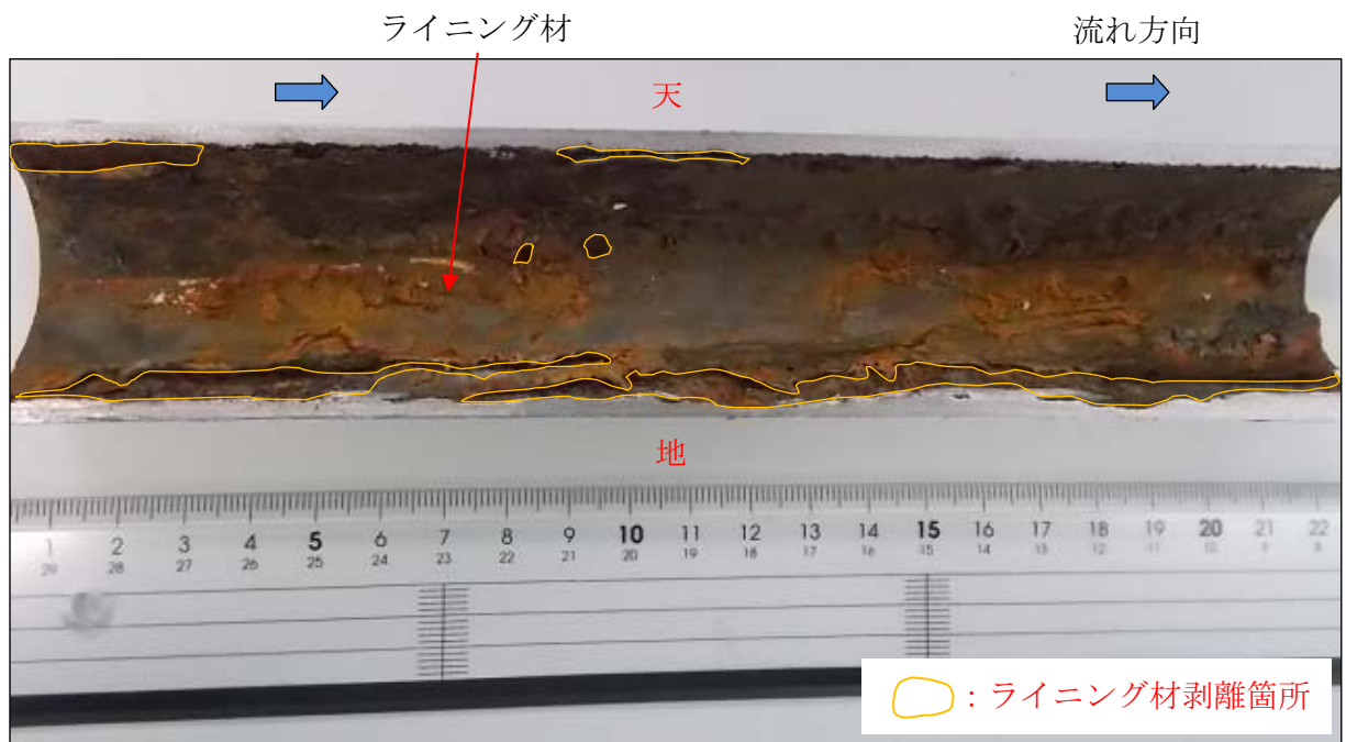
流れ方向から見て左側配管内表面
