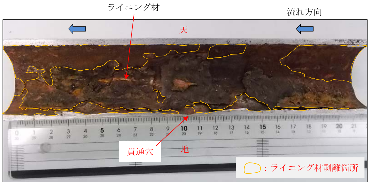
流れ方向から見て右側配管内表面
