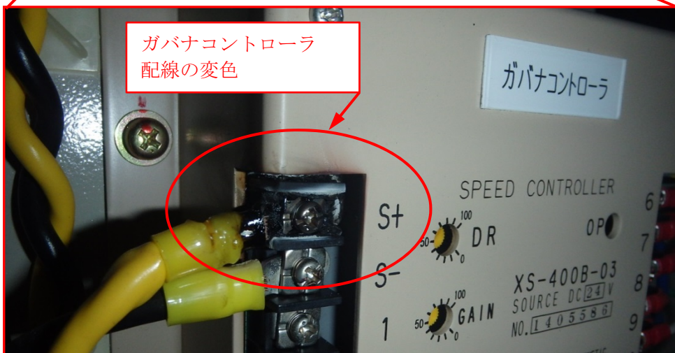
300kVA 電源車 今回事象発生時の状況
