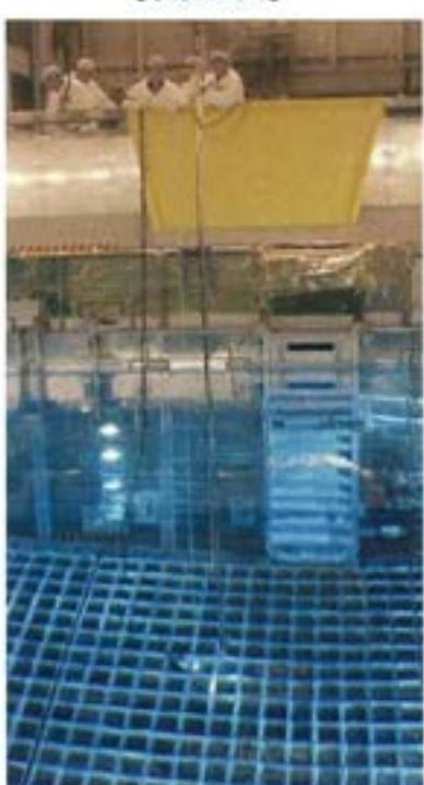
図-2 制御棒クラスタのスパイダ頭部内堆積物除去の概要図
