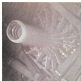
【原子炉格納容器内】
