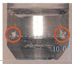
図 4 接手外面円筒部の 局所的接触痕
