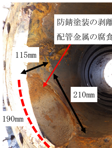
漏えい箇所内面写真
