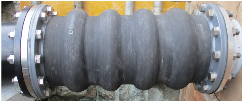
復旧状況写真
