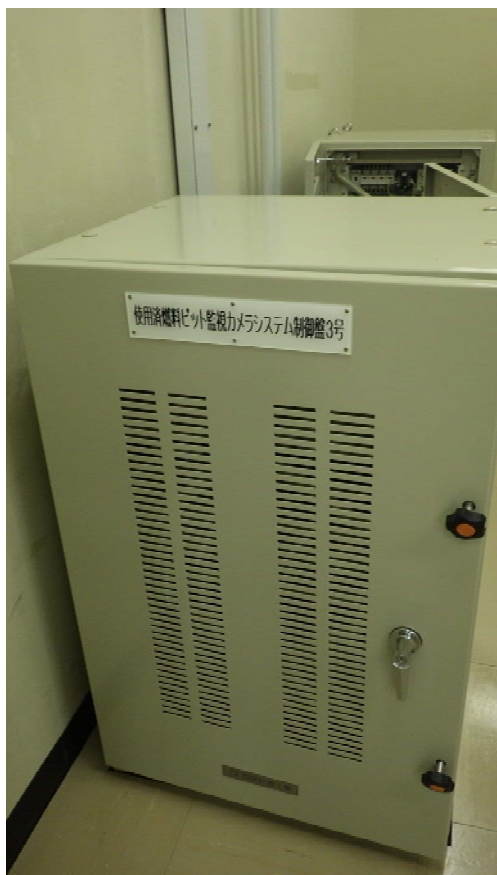
監視カメラ制御システム制御盤(左:扉開放前、右:扉開放後)
