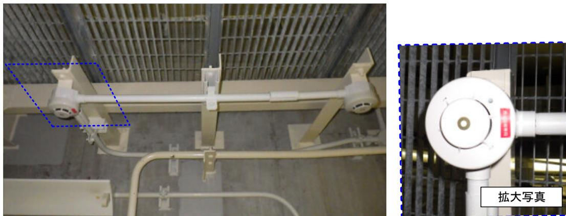
図2 火災感知器 設置状況 (取り替え後)
