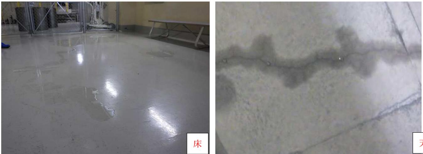
高圧圧縮棟内の水漏れ状況（拭き取り状況）
