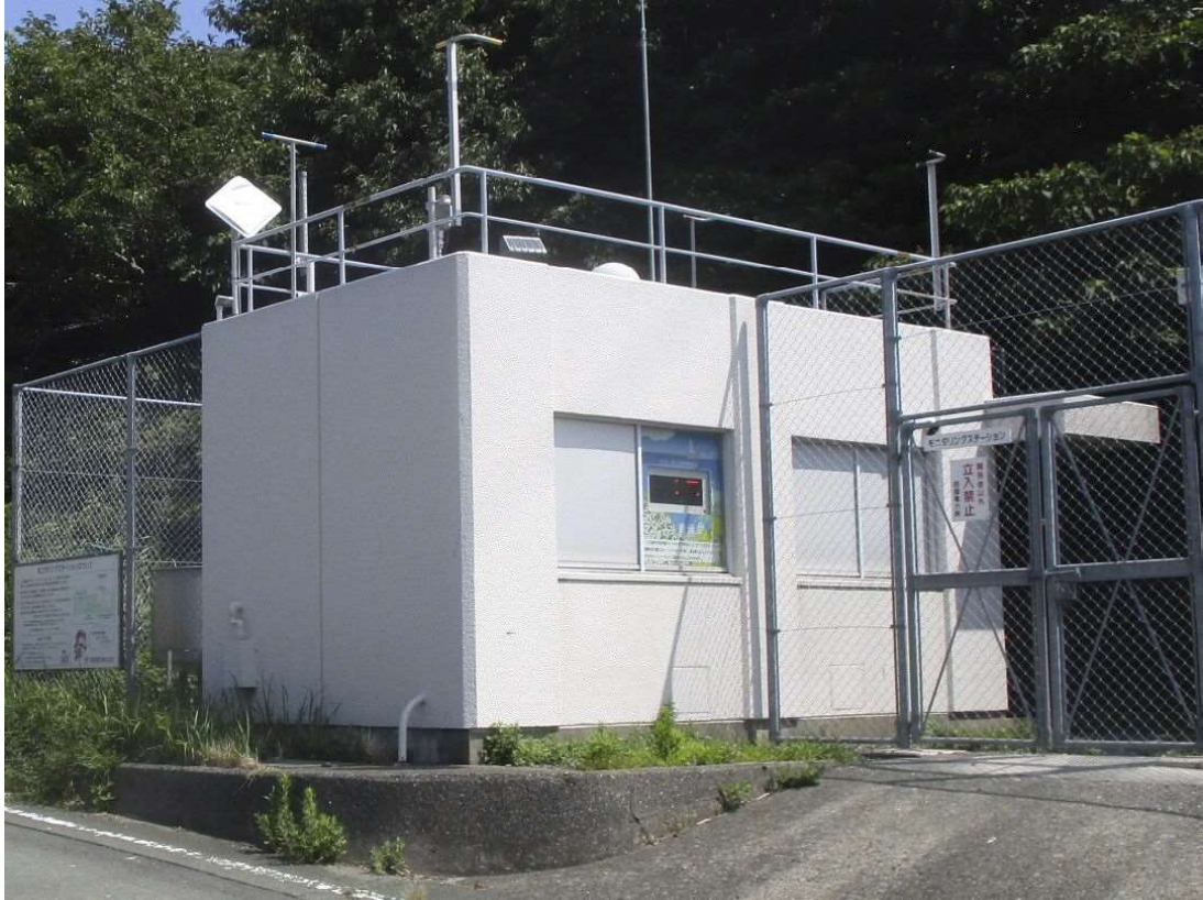
モニタリングステーションの外観
