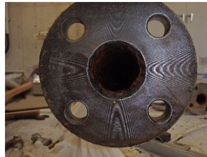
排水配管内面屋外側
