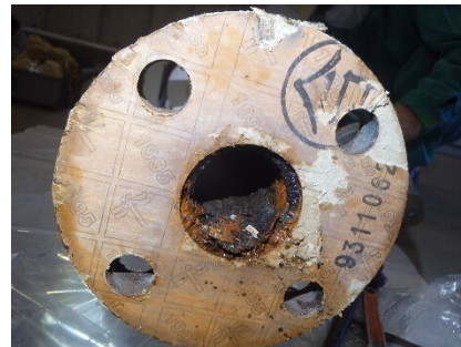
排水配管内面屋外側 (矢視②)
