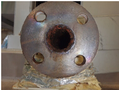
排水配管内面ユニット側
