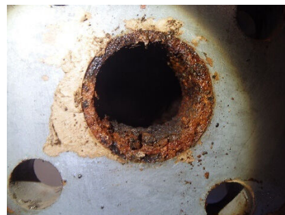
逆止弁内面屋外側 (矢視④)
