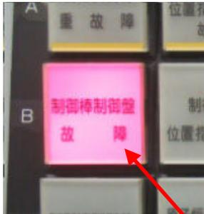
「制御棒制御盤故障」点灯
