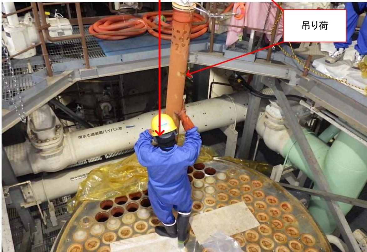
発災時は、吊り荷（モジュール）を復水ろ過器に収納した後、吊り荷（モジュール）から吊具の取り外しを行っていた際に、負傷者へ吊り具が4m上方から落下し、負傷した。
