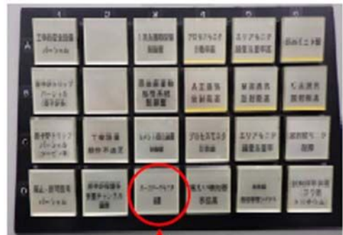
「ルースパーツモニタ装置」消灯
