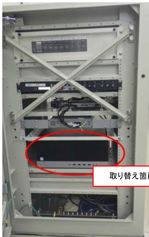
使用済燃料ピット監視カメラシステム制御盤(左:扉開放前、右:扉開放後)
