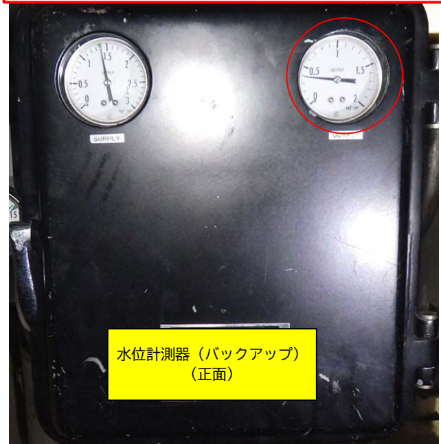
水位制御の状況(復旧後)
