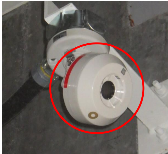
取り替え後（ランプ消灯）
