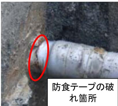
伊方発電所 機材保管庫 消火配管 復旧状況
