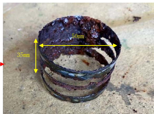
仮設ホース内に残った折損した短管 (取り出し後)
