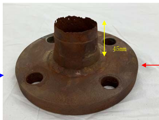
折損した短管付きフランジ
