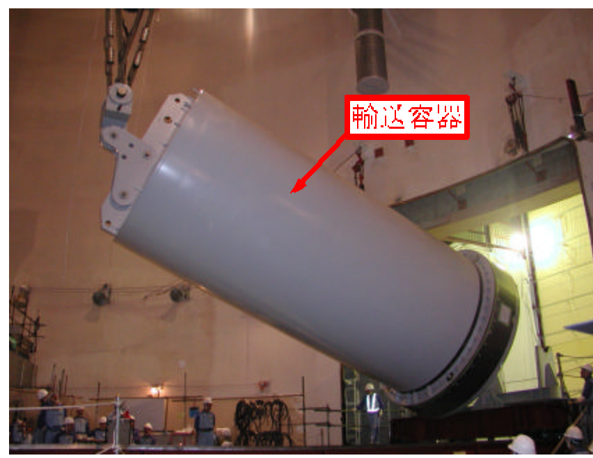
新上部ふた立起し状況 (平成13年10月13日撮影)
