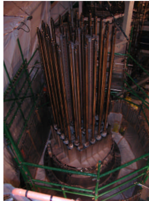
旧上部ふた（解体後）状況 （平成13年10月13日撮影）
