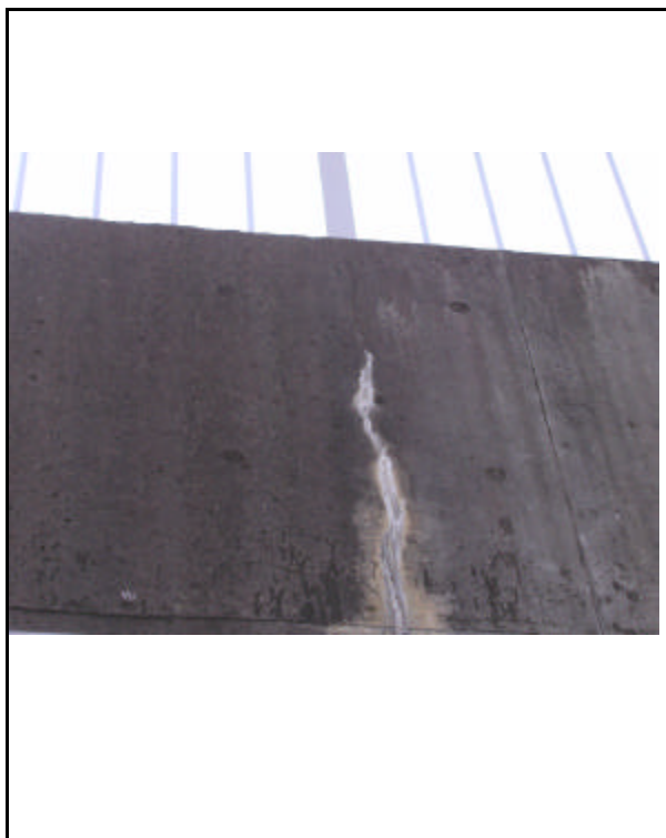
3号機海水ピット
