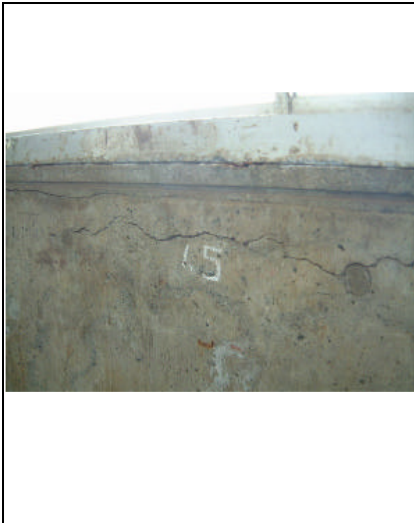
1, 2号機 海水淡水化装置建家内壁
