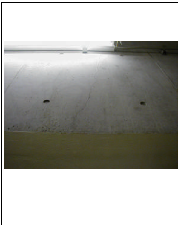
その他建家 蒸気発生器保管庫)内壁
