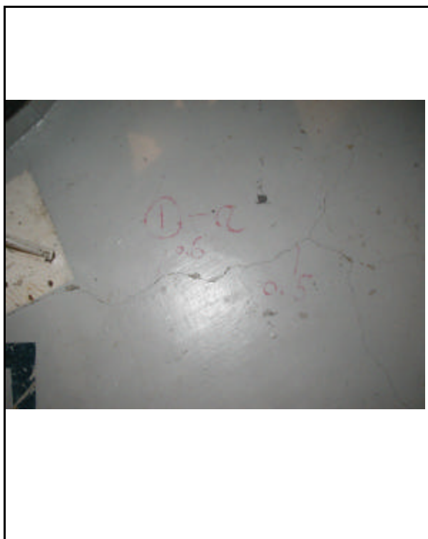
1号機 原子炉格納容器内床
