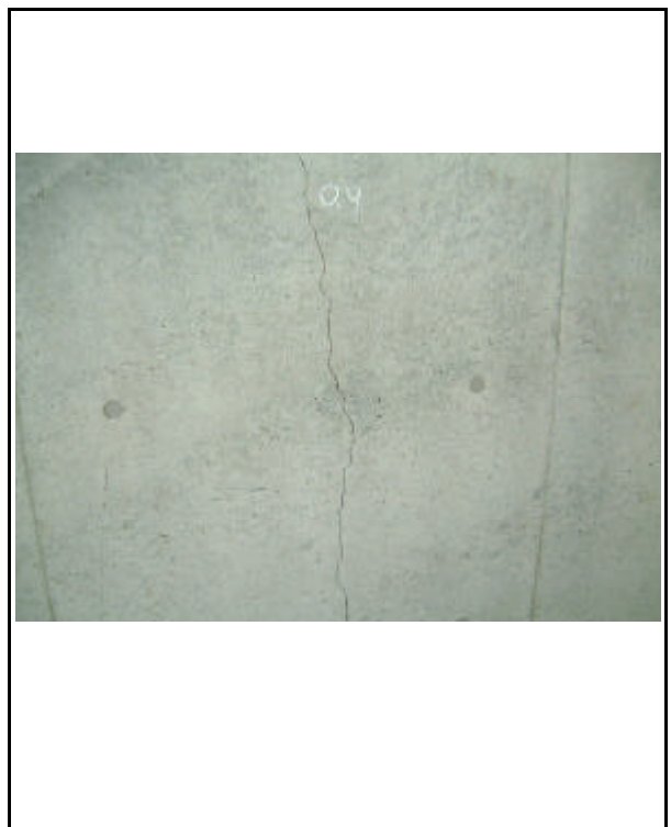
その他建家 (ﾀｰﾛｰﾙｱﾐﾝ排水処理装置建家)内壁
