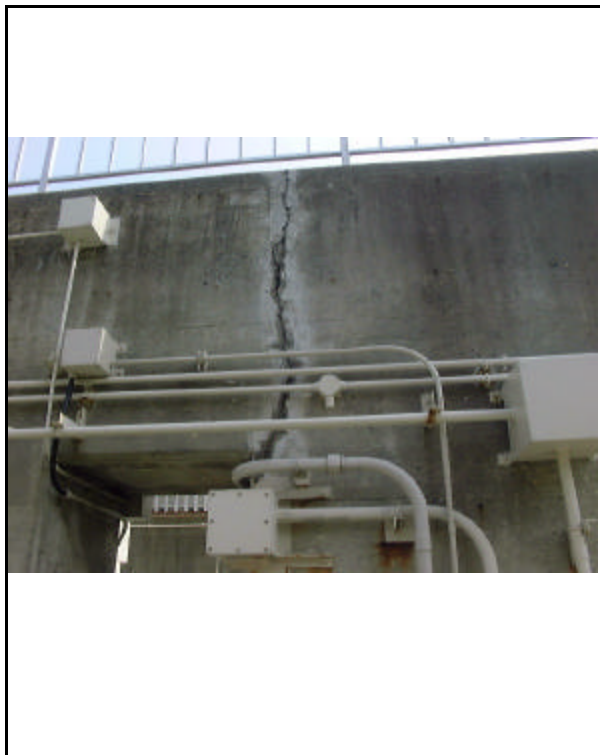
1, 2号機取水ピット
