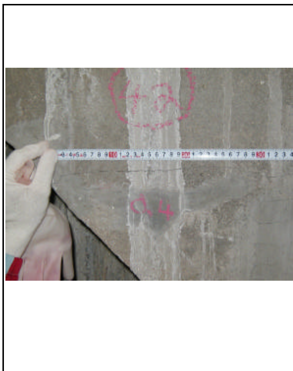
1号機 外部遮へいコンクリート壁
