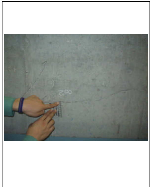
3号機 原子炉建家内壁
