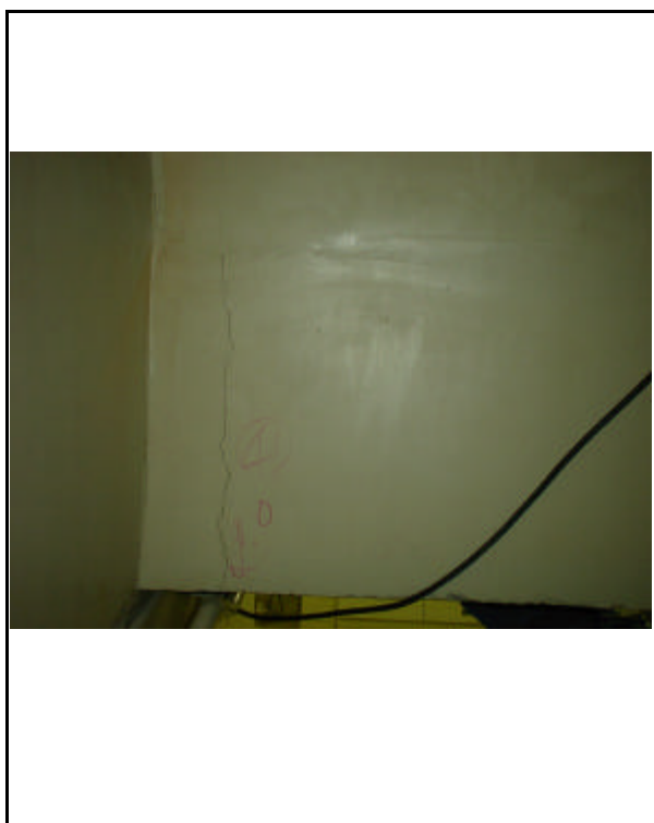
1号機 原子炉補助建家内壁
