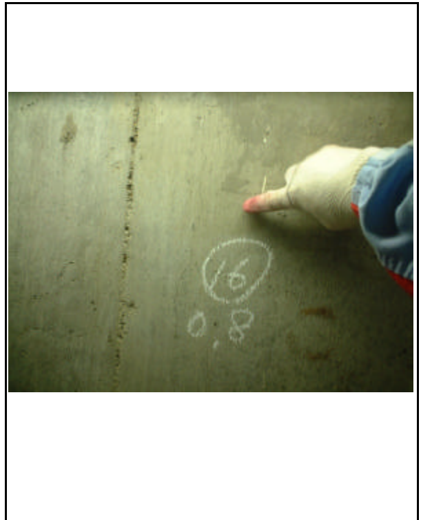
2号機 外部遮へいコンクリート壁
