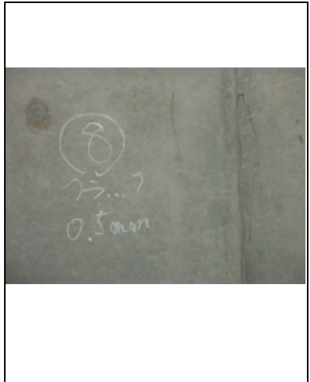
3号機 タービン建家 (タービン架台)
