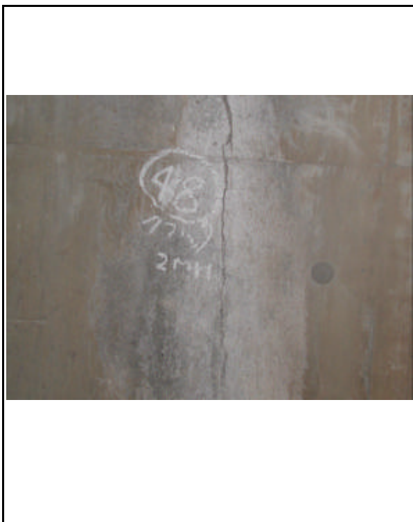
3号機 タービン建家内壁
