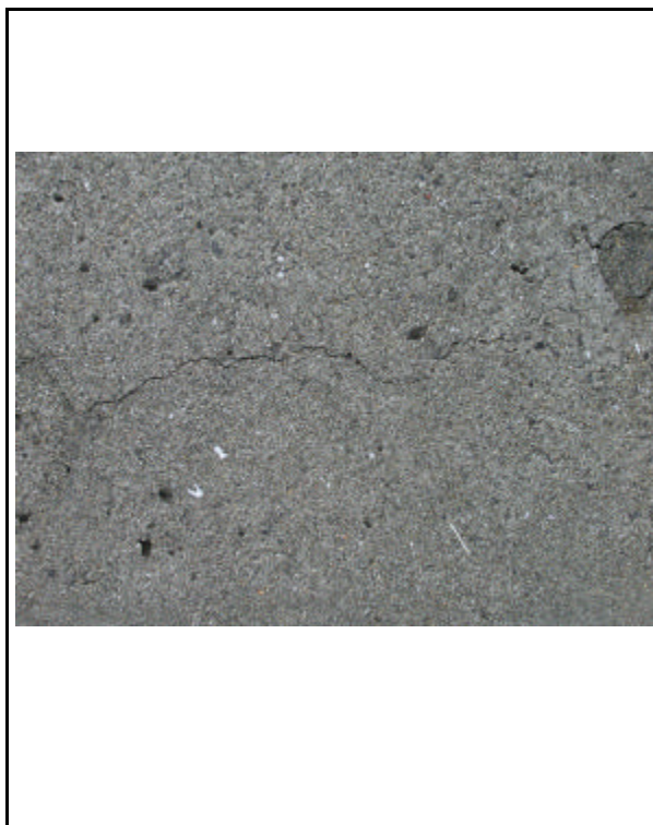
1, 2号機擁壁(A護岸裏擁壁)
