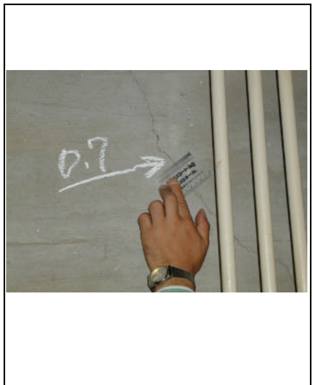
2号機 タービン建家内壁
