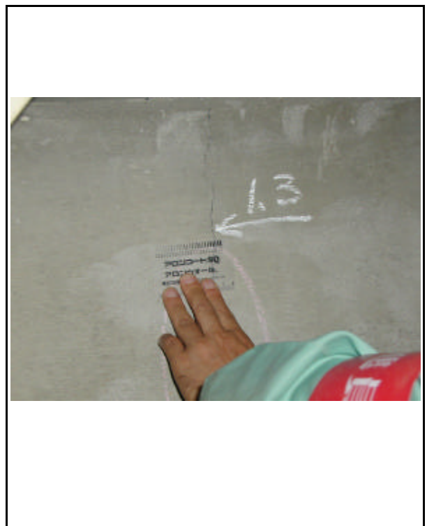
1, 2号機 屋内開閉所内壁
