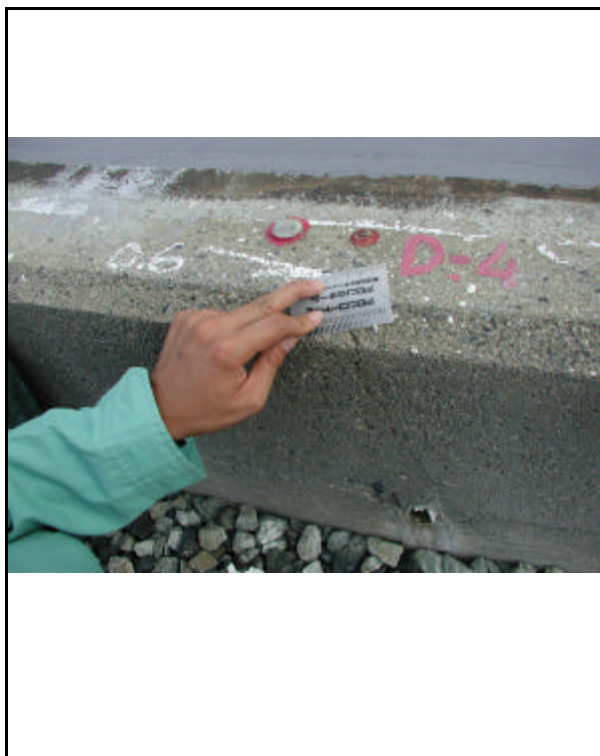
1, 2号機タンク基礎 脱塩水タンク)
