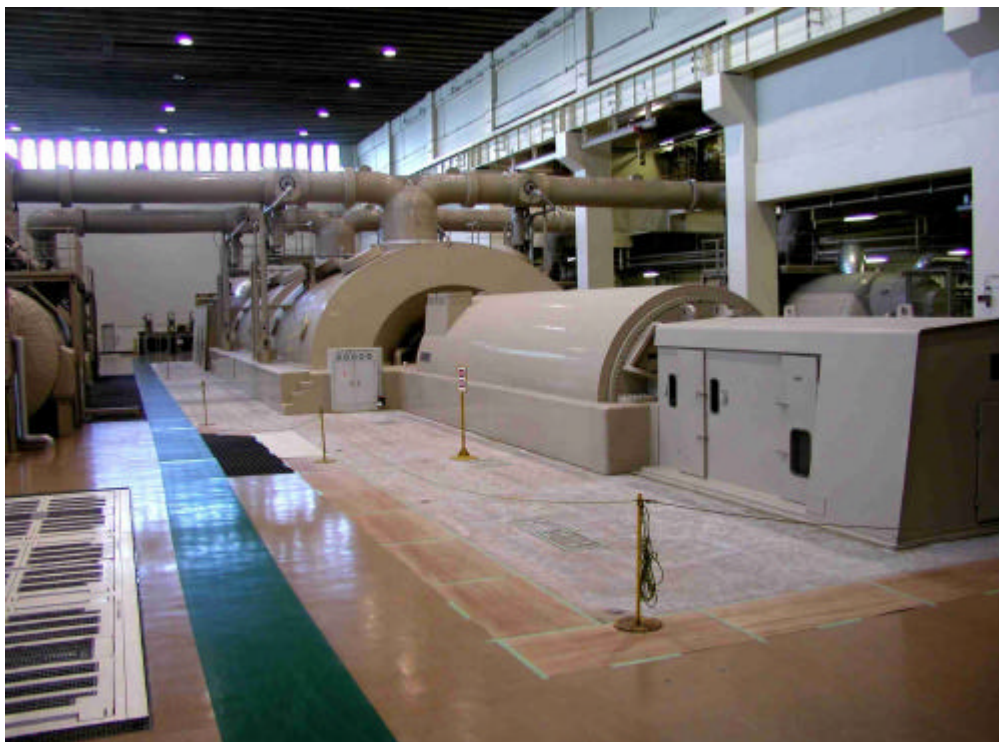
タービン架台 上面の全景(EL+17.2m・海側)
