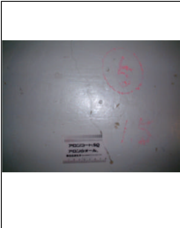
2号機 原子炉格納容器内床
