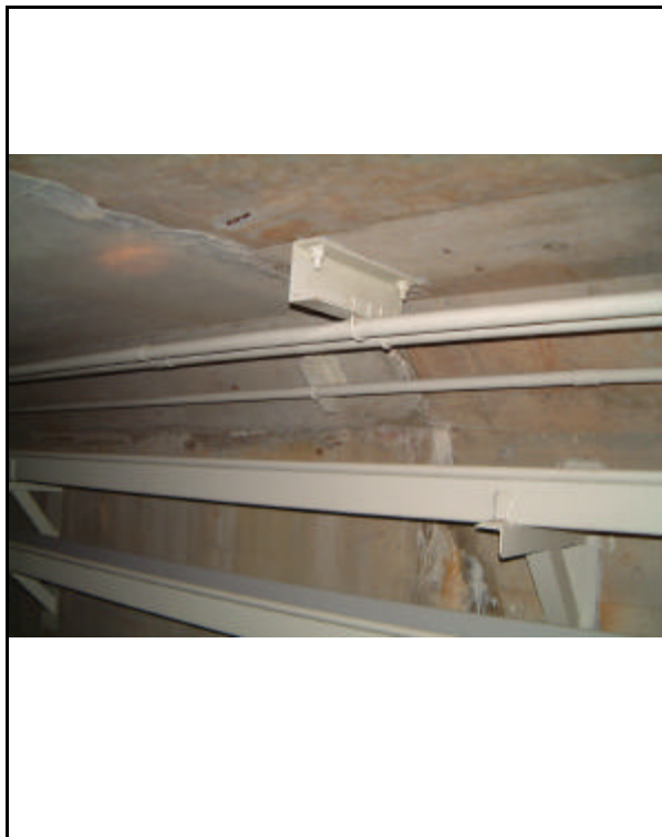
1, 2号機海水管ダクト
