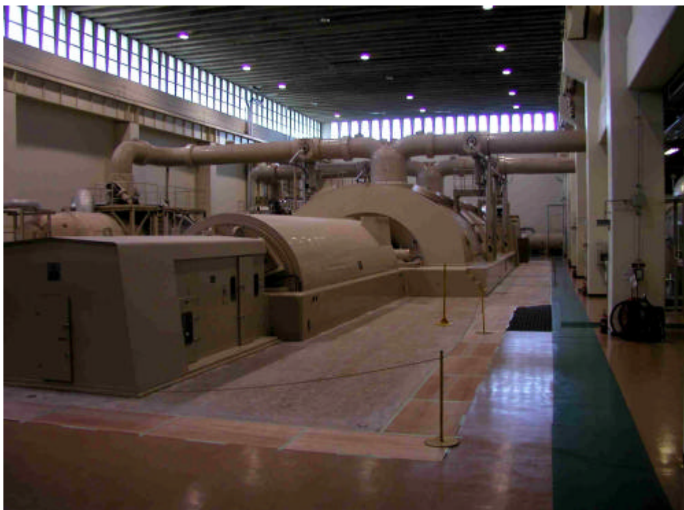
タービン架台 上面の全景(EL+17.2m・山側)
