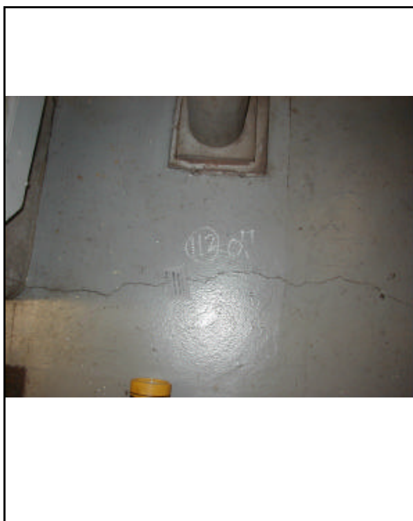
1号機 タービン建家内床
