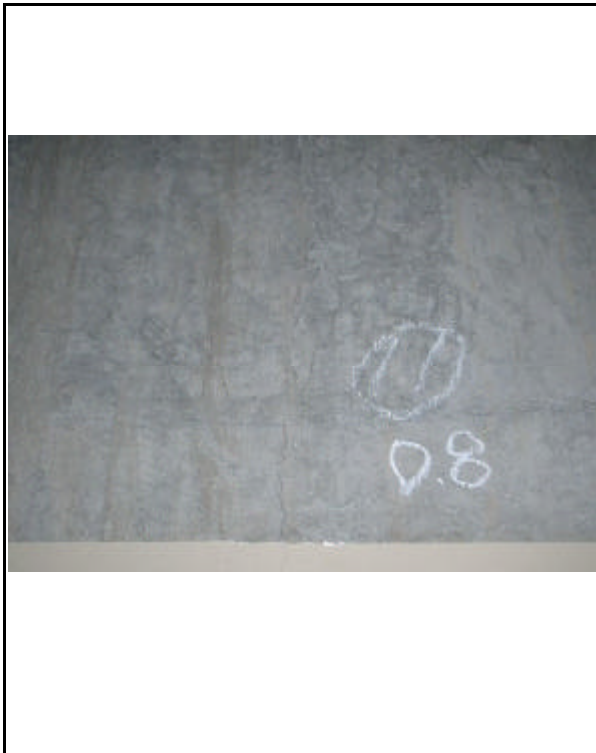
3号機 原子炉補助建家内壁
