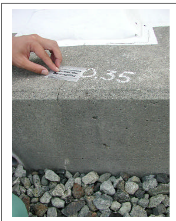
3号機タンク基礎 脱塩水タンク)
