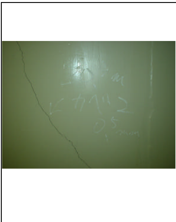
2号機 原子炉補助建家内壁
