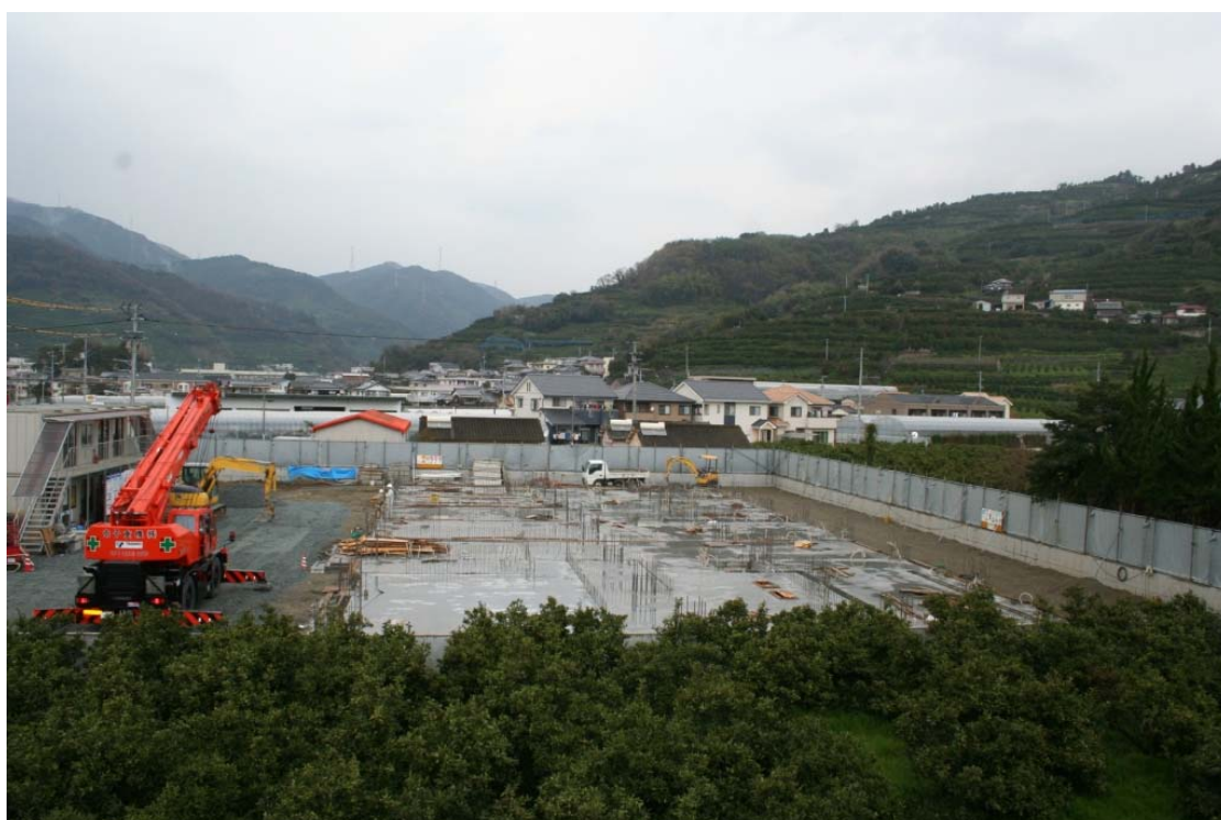
建設状況（平成22年3月現在）
