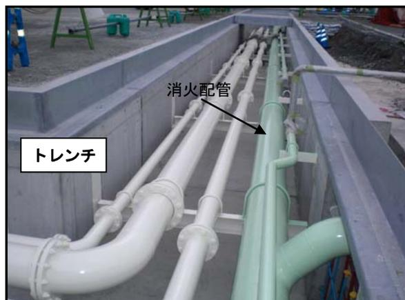
●埋設配管を地上化（トレンチ内へ移設）
