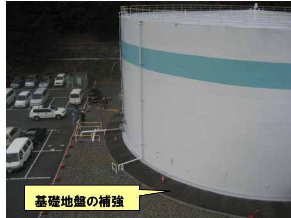
ろ過水タンクB地盤補強
