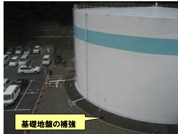
ろ過水タンクB地盤補強
