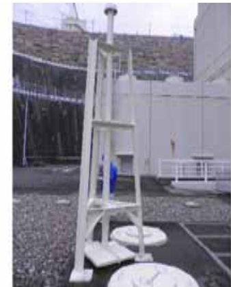
DG 燃料油貯油槽の換気孔
