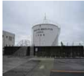
補助ボイラ燃料タンク (T. P. +10m)
