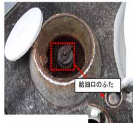
DG 燃料油貯油槽の給油口 (取出口)
