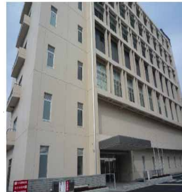
緊急時対策所
