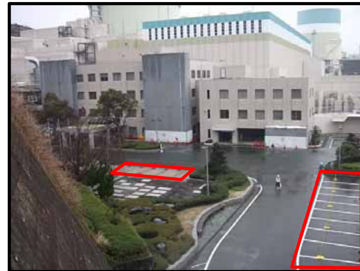
3号機DG燃料油貯油槽 (地下タンク)
