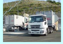
空冷式非常用発電装置
