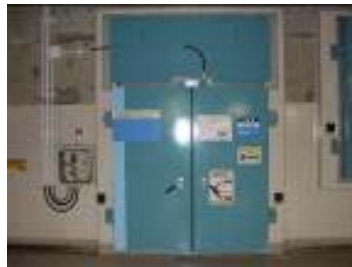
図2 浸水対策箇所例(水密扉)
