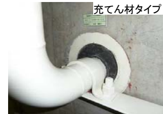
図3 浸水対策箇所例(建屋壁貫通部シール)
