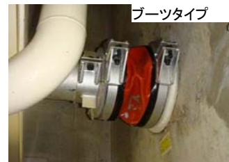
図3 浸水対策箇所例(建屋壁貫通部シール)
