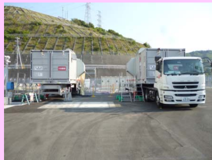
空冷式非常用発電設備
