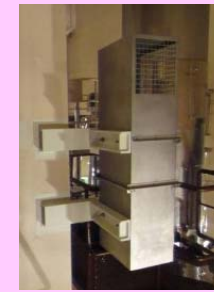
【 設置した水素爆発の防止設備 】
