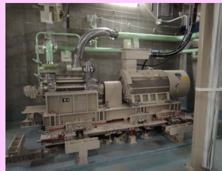
蒸気発生器代替注水ポンプ
