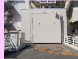
原子炉補助建屋EL10.0m機器搬入
