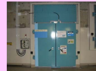
原子炉補助建屋EL3.3m入口扉
