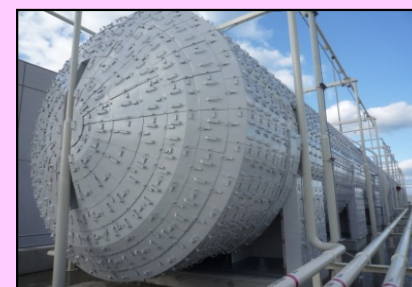
竜巻防護対策設備 (例：重油タンクの防護（衝撃吸収材）)
