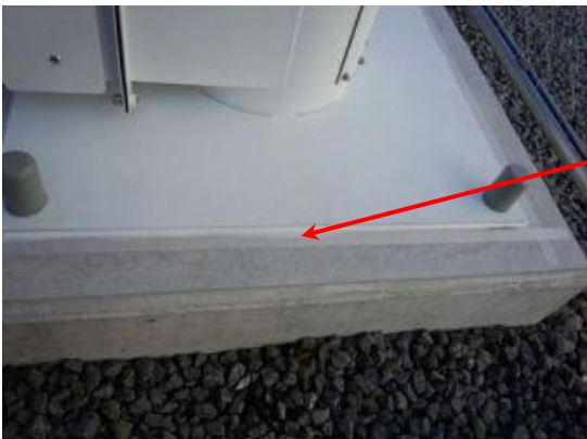
検出器架台のコーキング状況
