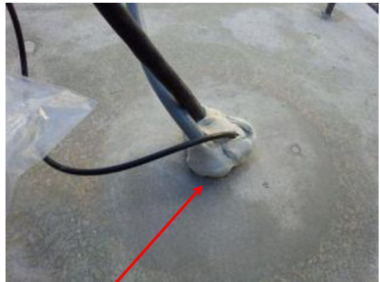
架台配線部のコーキング状況
