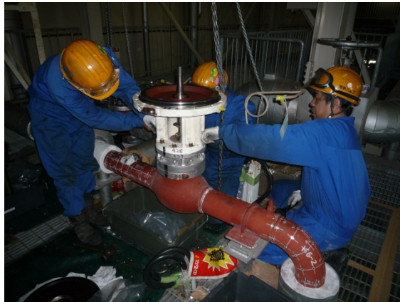
⑤空気作動弁分解点検状況
