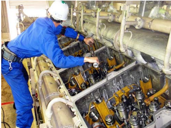
①非常用ディーゼル発電機機関分解点検状況
