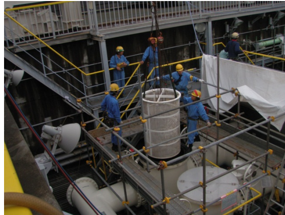
②海水管(ストレーナ)開放点検状況
