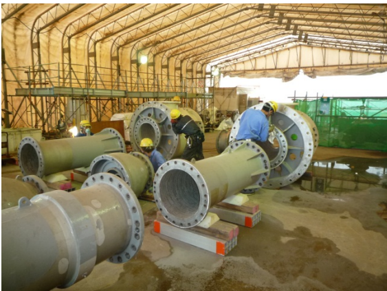
④海水ポンプ分解点検状況
