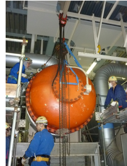
③原子炉補機冷却水冷却器開放点検状況
