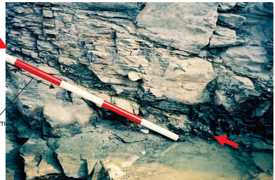
※基礎掘削面で平成2年撮影
