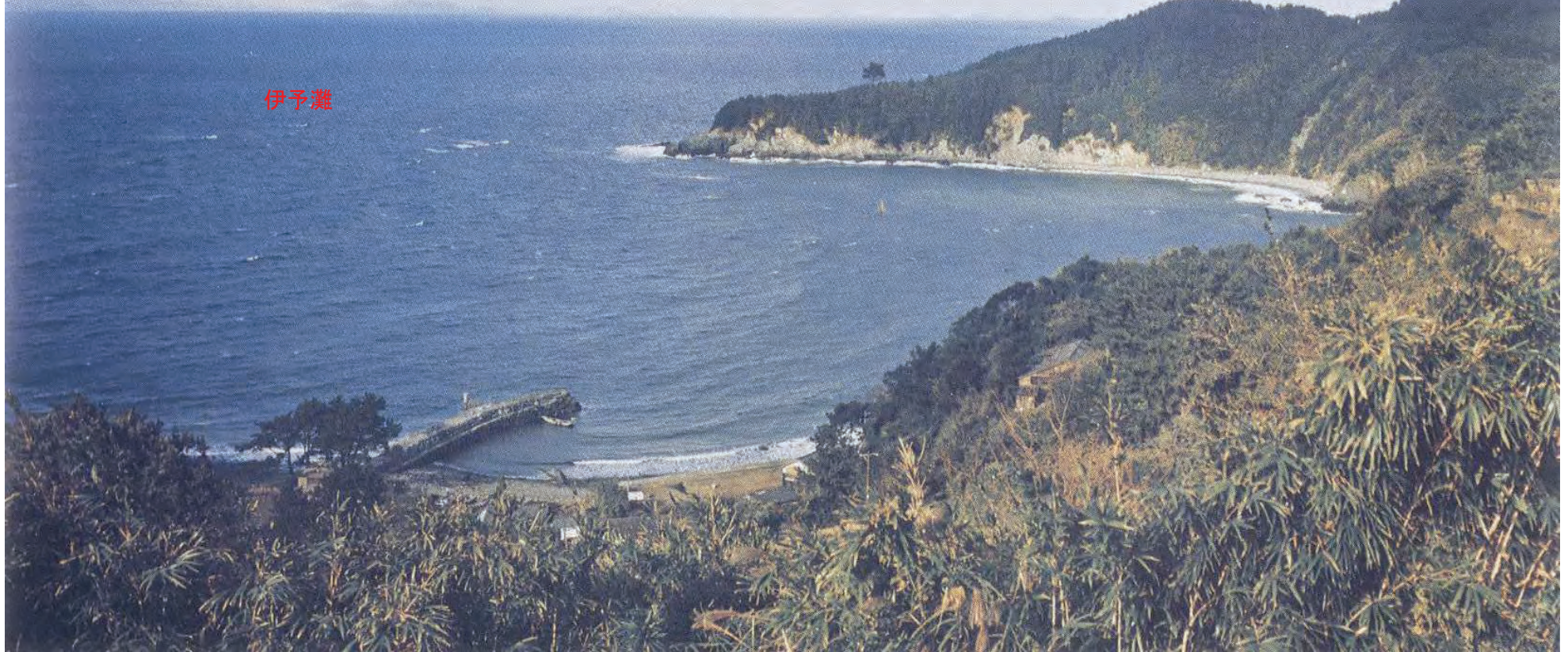
発電所建設前の遠景
