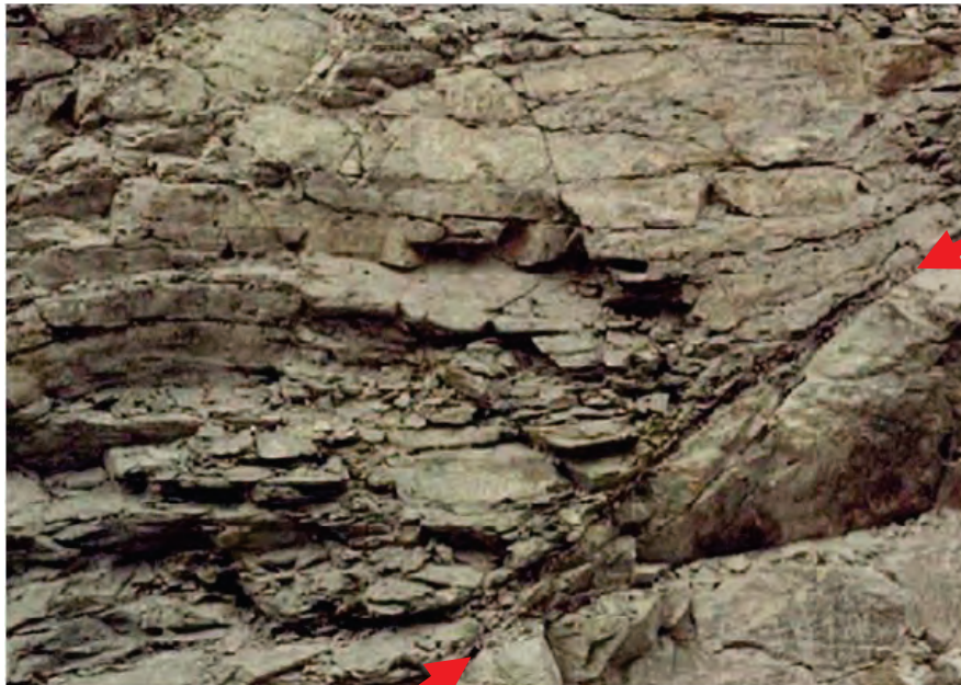
※基礎トレンチ内で昭和51年撮影
