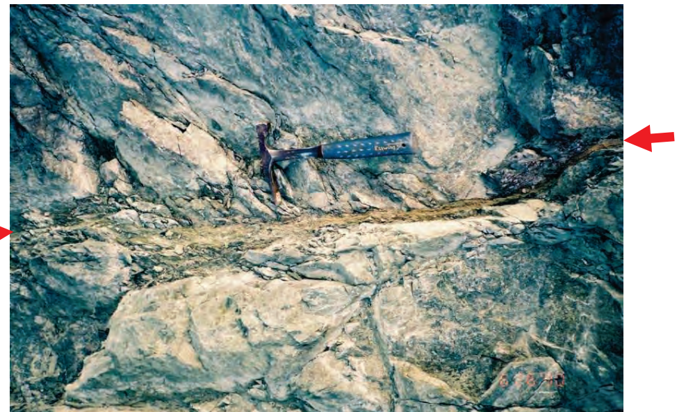
※試掘坑南方の基礎掘削面で平成2年撮影
