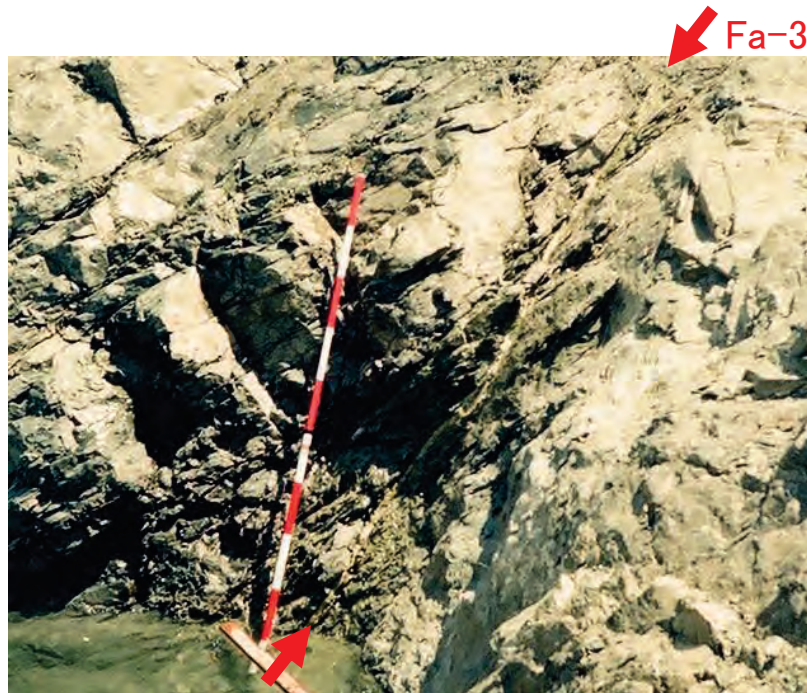
※試掘坑付近から掘り下げた基礎掘削面で平成2年撮影
