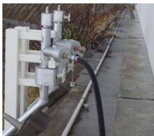
重油移送配管
