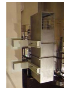
静的触媒式 水素再結合装置
