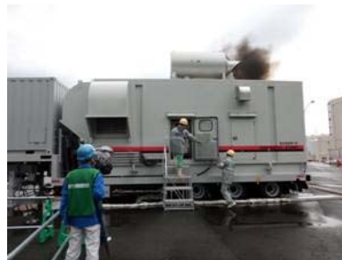
空冷式非常用発電設備
