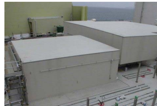
緊急時対策所(EL.32m) [写真は工事中]
