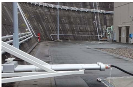
軽油移送配管
