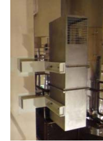
静的触媒式 水素再結合装置
