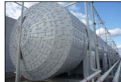
竜巻防護対策設備 (例：重油タンクの防護（衝撃吸収材）)
