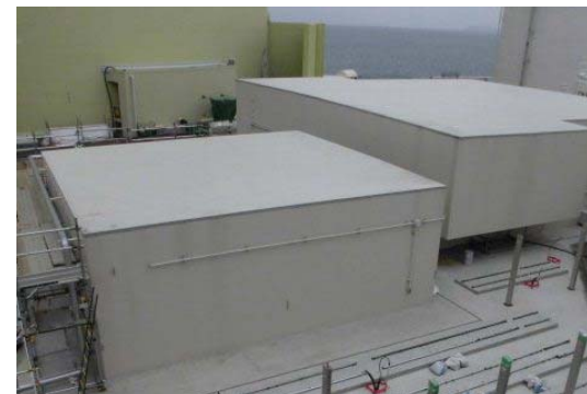
緊急時対策所(EL.32m) [写真は工事中]
