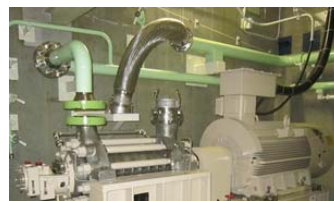
蒸気発生器代替注水ポンプ
