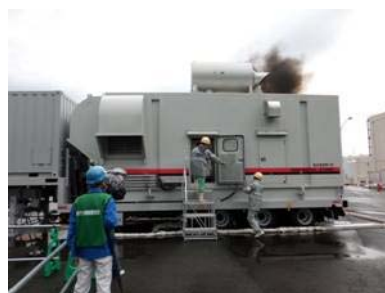
空冷式非常用発電設備
