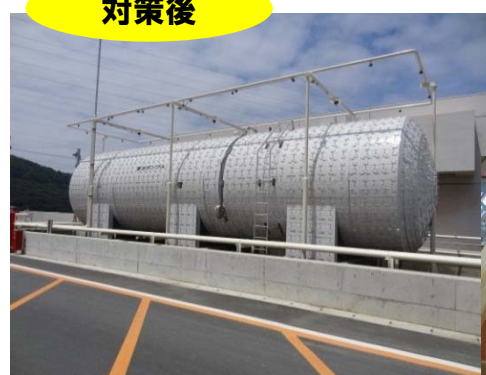
竜巻防護対策設備 (例:重油タンクの防護(緩衝材))
