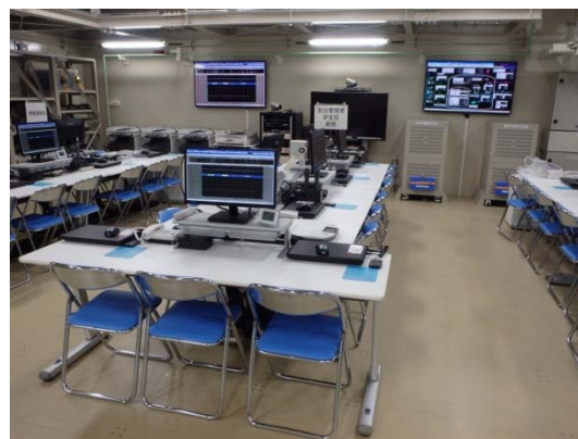
緊急時対策所 (EL.32m) 内部
