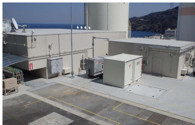
緊急時対策所 (EL.32m) 外観
