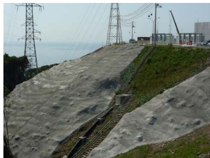
周辺の樹木を伐採しモルタルを吹付
