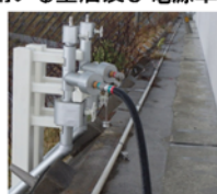
重油移送配管
