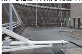
軽油移送配管
