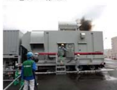
空冷式非常用発電装置
