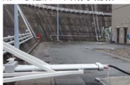
軽油移送配管
