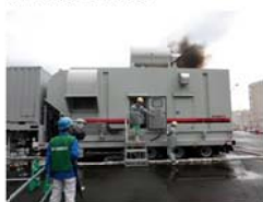
空冷式非常用発電装置
