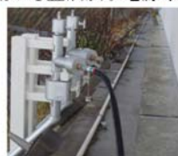
重油移送配管
