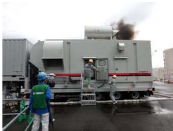
空冷式非常用発電装置
