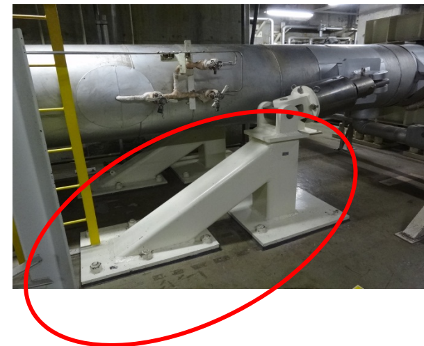
配管の耐震補強工事
