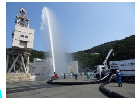
原子炉格納容器への放水
