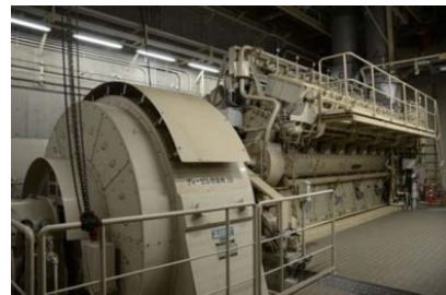
ディーゼル発電機（既設）
