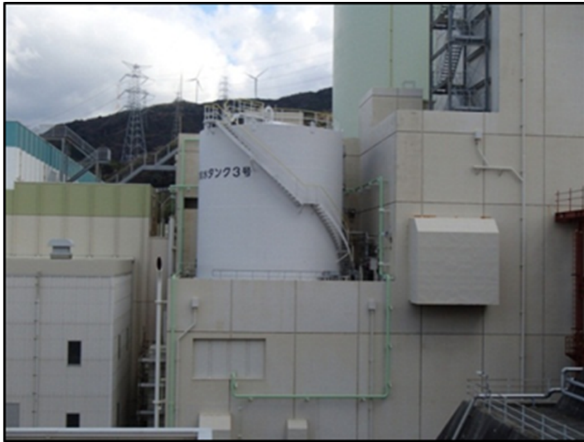
【防護対策実施前】
