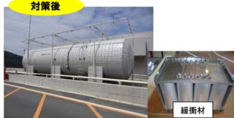
竜巻防護対策設備 (例:重油タンクの防護(緩衝材))
