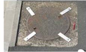
飛来物発生防止対策 (例:マンホール蓋の固定)
